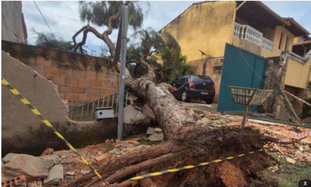
📷 Queda de árvore na Rua Macadâmia, no bairro Tirol, na Região do Barreiro, em BH, atingiu muro e garagem de casa crédito: Jair Amaral/EM/DA Press
