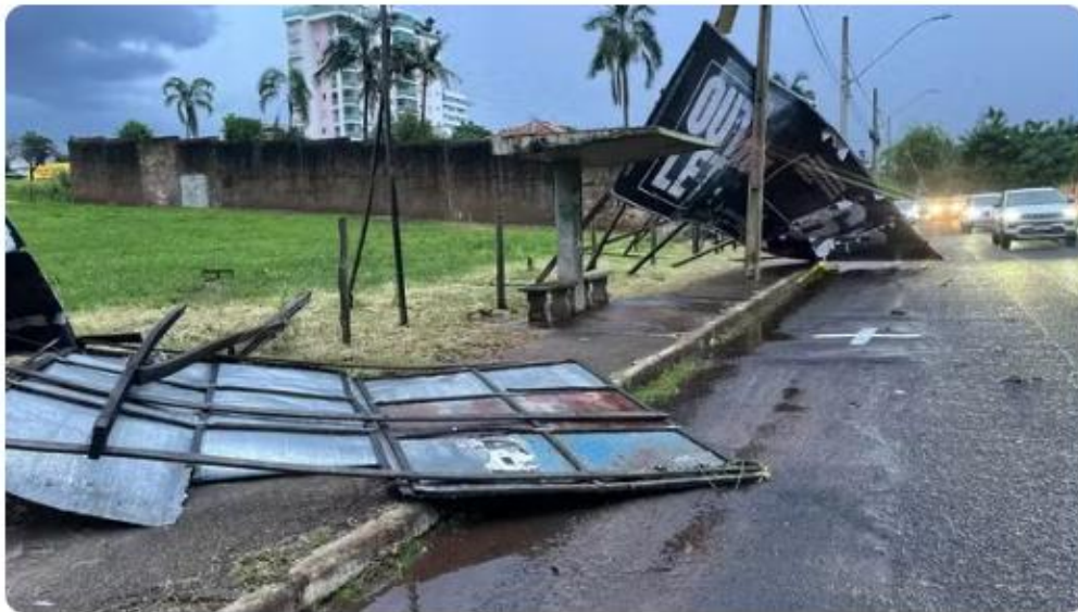
Outdoor caiu na Avenida Francisco Galassi, na zona sul de Uberlândia — Foto: João Ricardo/TV Integração
