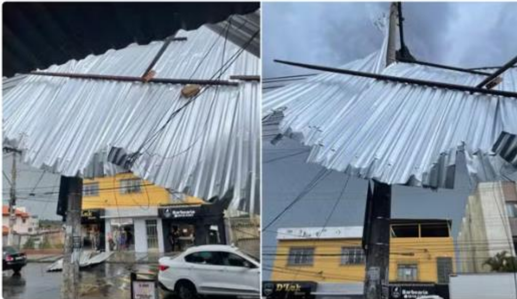
Telhado que se soltou de imóvel no bairro Santa Inês, região Leste da capital — Foto: Acervo Pessoal
