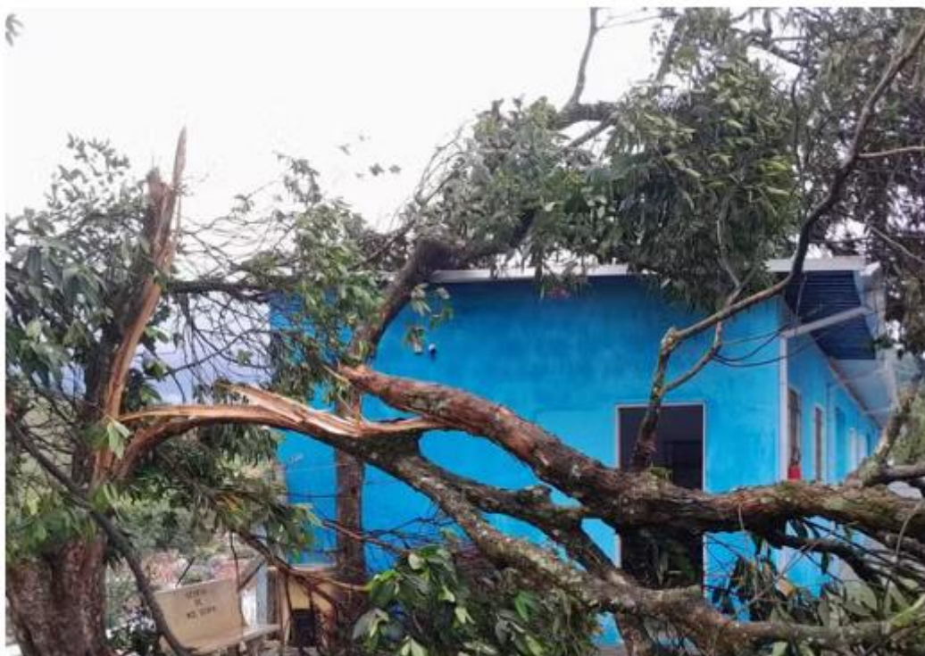
Chuva com ventos destelha casas e derruba mais de 30 árvores em Brazópolis — Foto: Defesa Civil
