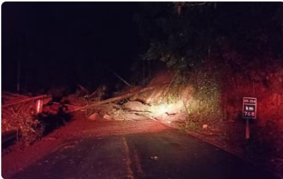
BR-354 é interditada após queda de barreiras pelas chuvas em Itamonte — Foto: Polícia Rodoviária Federal
