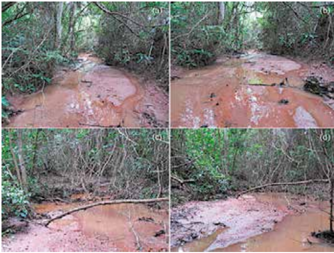
Figura 5: Imagens da cabeceira do córrego Pedra Branca em Catalão, GO, Brasil e do estado de assoreamento de alguns de seus trechos. Notar a presença da mata ciliar ainda preservada.
