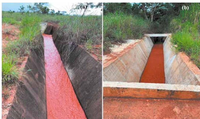
Figura 3: Imagens da cabeceira do córrego Pedra Branca em Catalão, GO, Brasil. Imagens das estruturas de drenagem de concreto instaladas na área do PRAD para controle da água pluvial. Profundidade 1,60m, larguras 1m e 1,50m no fundo e 2,50m de abertura.
