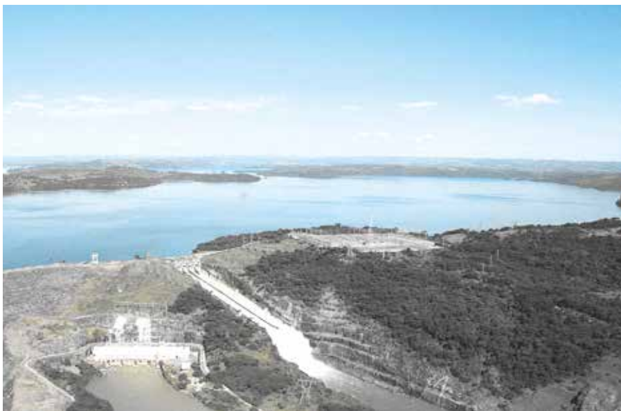
Figura 1- Vista panorâmica da Usina Hidrelétrica de Emborcação, Araguari, MG.
