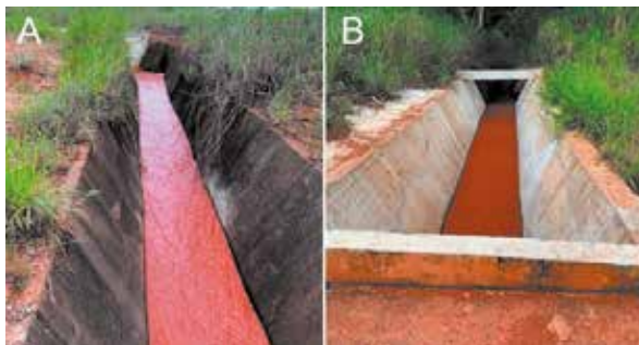
Figura 11: Canaleta de concreto, com água pluvial e sedimentos, que desagua no Riacho Pedra Branca em Catalão, GO.
