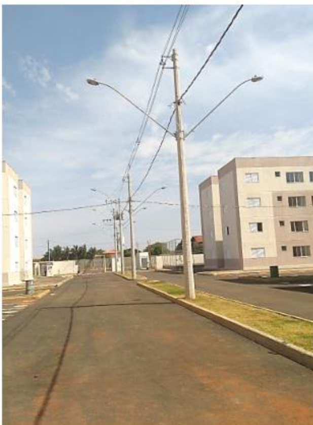
Figura 12: Alocação de Postes em Canteiro Central
