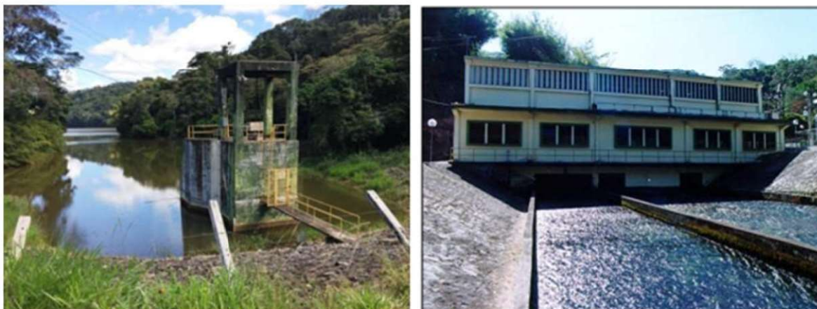
Figura 1 – Tomada d'água (esquerda), casa de força e canal de fuga da PCH Tronqueiras (direita)
