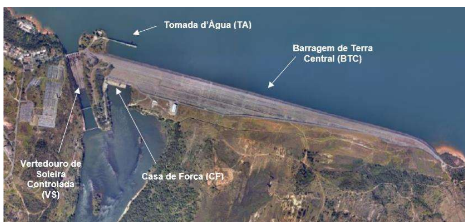
Figura 1 - Vista superior das estruturas
