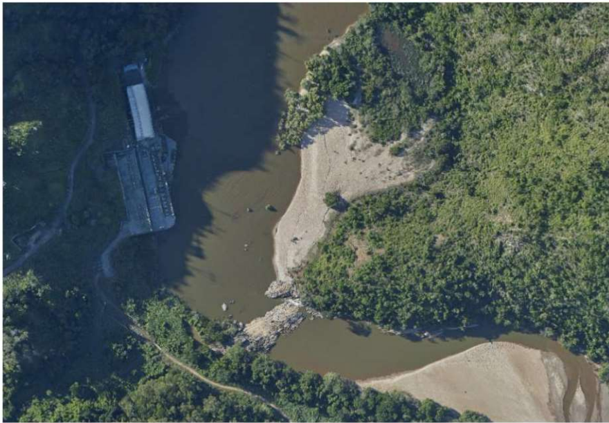
Figura 3 – Vista superior da casa de força
