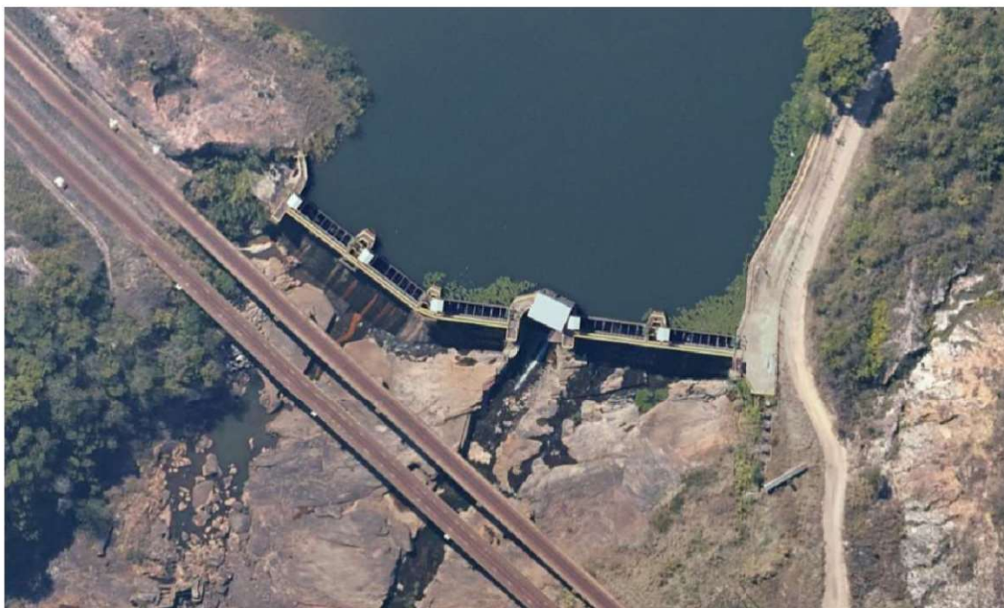
Figura 1 - Vista superior da barragem Antônio Dias
