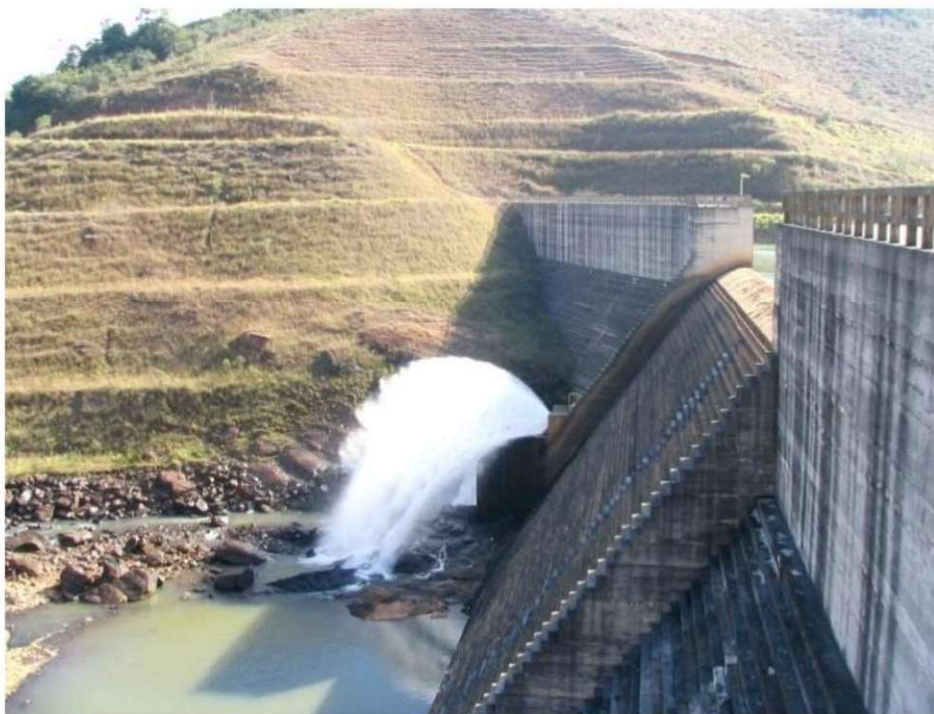
Figura 1 - Vista lateral a jusante da barragem
