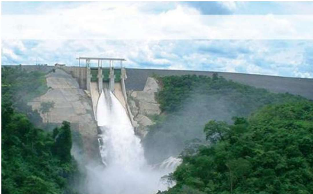
Figura 1 - Vista da barragem e vertedouro
