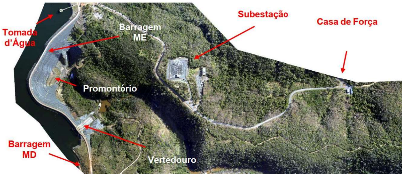
Figura 2 - Vista superior da UHE Queimado
