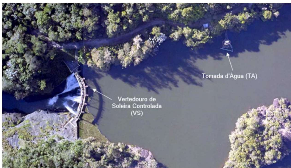
Figura 1 - Vista da barragem e vertedouro
