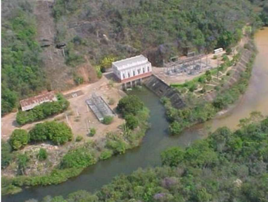
Figura 2 – Casa de força
