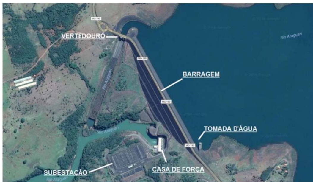
Figura 1 - Vista da barragem e vertedouro
