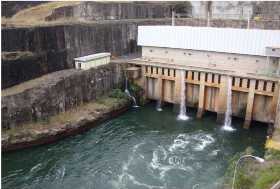
Figura 2 – Casa de força
