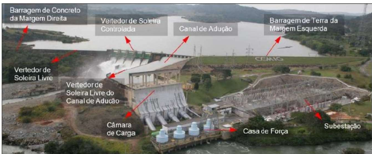
Figura 1 – Vista das estruturas do empreendimento
