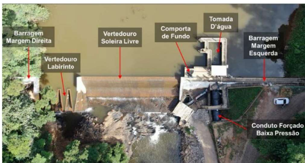
Figura 1 – Vista geral do barramento, com indicação das estruturas.
