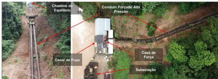
Figura 2 – Vista geral do circuito de adução, com indicação das principais estruturas.
