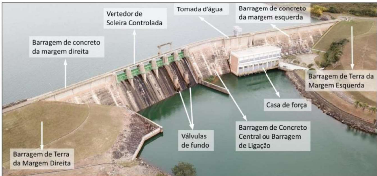
Figura 1 – Vista das estruturas do empreendimento
