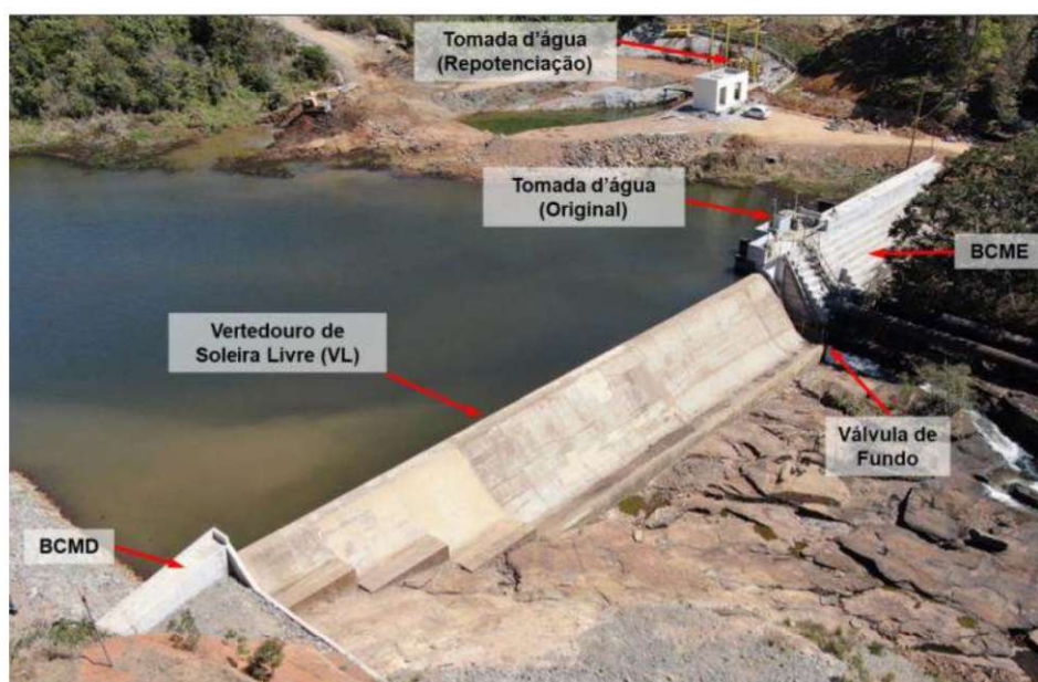
Figura 1 – Estruturas do barramento
