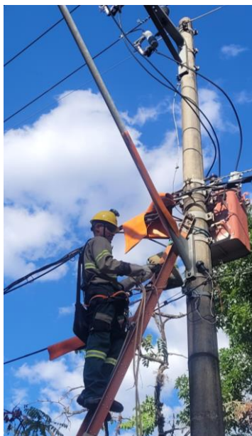
Figura 2 - Ligação nova com o eletricista próximo ao jumper de MT.
