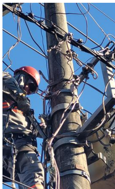
Figura 3 - Troca de transformador com MT energizada.
