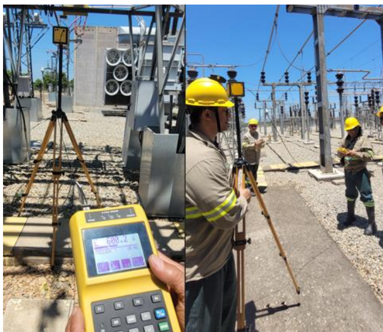
Figura 13 - Testes com o analisador de campo elétrico – SE “NEVES-1”.
