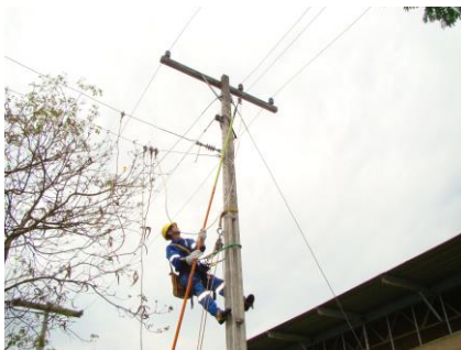
Poste da rede tronco
