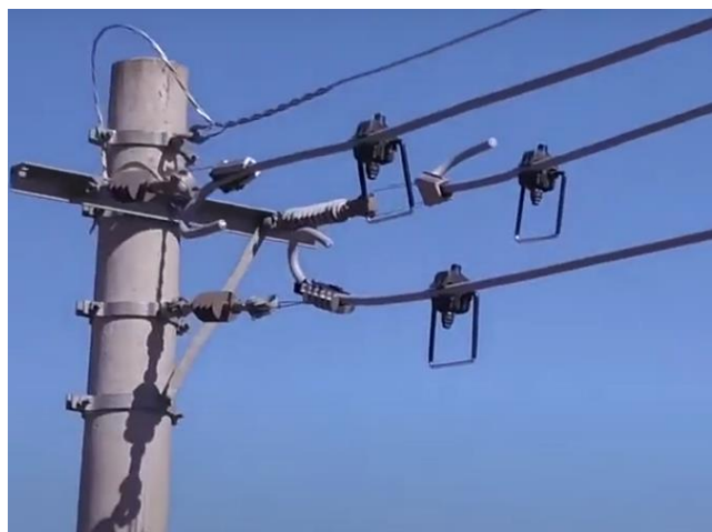
Figura 2 Conector Derivação Perfuração Com Estribo
